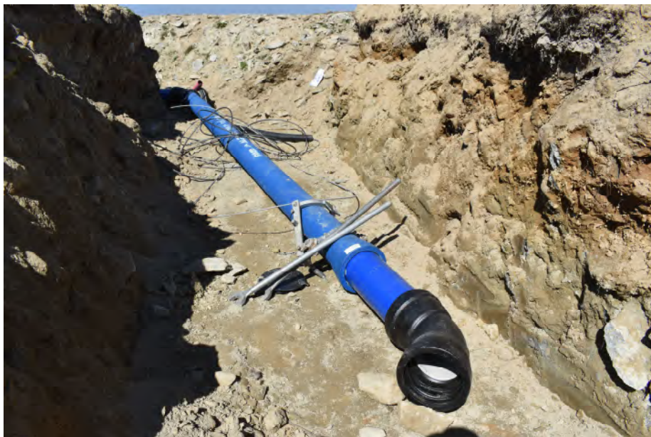
Particolare di condotta in ghisa da 200 mm di diametro
