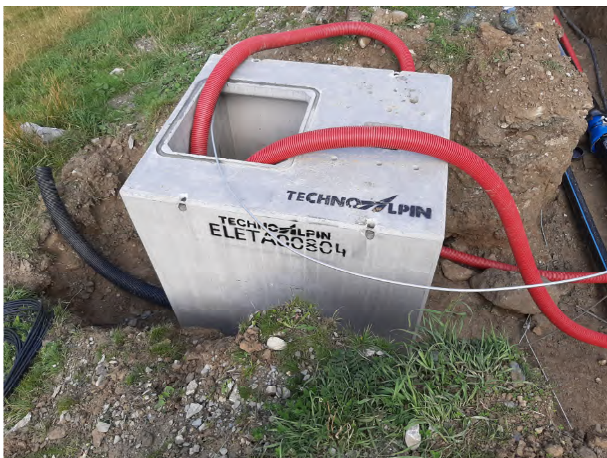
Particolare di pozzetto prefabbricato in corso di installazione
