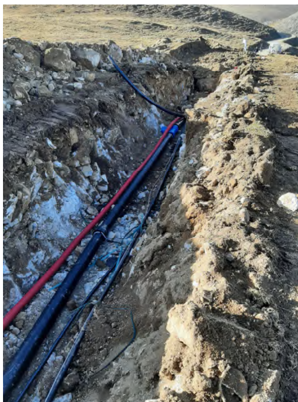
Trincea di scavo con in evidenza i sottoservizi di linea
